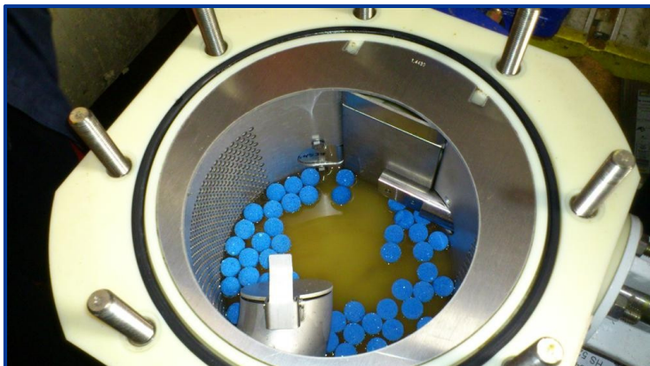
Bolluppsamlare med rengöringsbollar synliga
