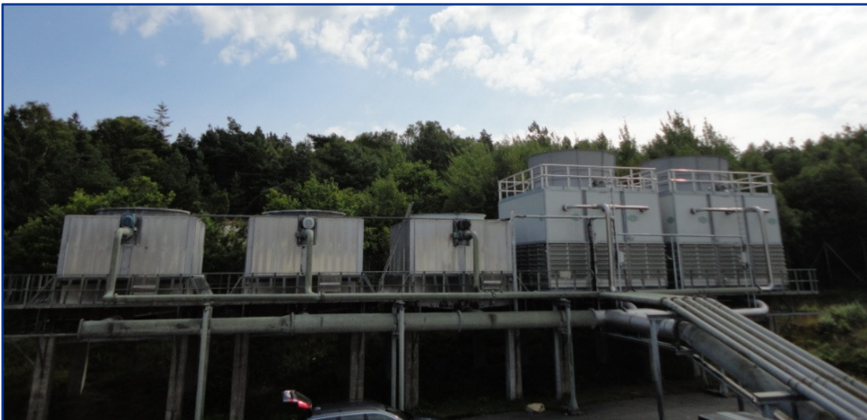
Etapp 1, två torn bytta
